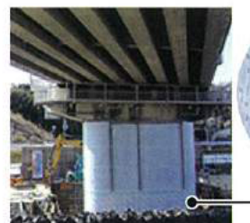
耐震補強・コンクリート巻き立て工
